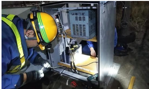
踏切器具箱取替
