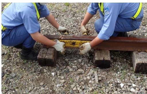
線路復旧訓練
