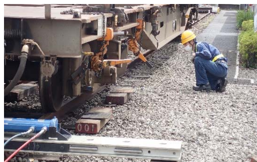
車両脱線復旧訓練
